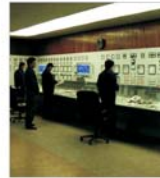
Rețelele de distribuție a agentului termic nu vor fi reabilitate în Clărași ○ pag. 12
