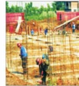
Județul Iași are nevoie de două miliarde de euro pentru construcția de locuințe
