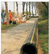
"Condmag" a construit mai mult de 90% din infrastructura industriei de gaze din țara noastră
