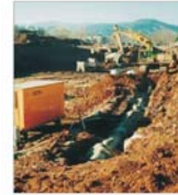
Rețele de termoficare în curs de modernizare a Suceava
