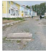
Firmele implicate vor plăti pentru deficiențele constatate la ANL I din Călărași
