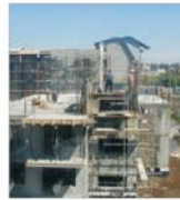
Șase blocuri noi vor înlocui o parte din halele "Roman"
